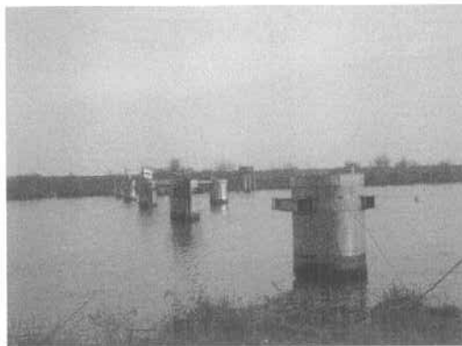
Barreras antisal en el Delta del Po (Italia)
