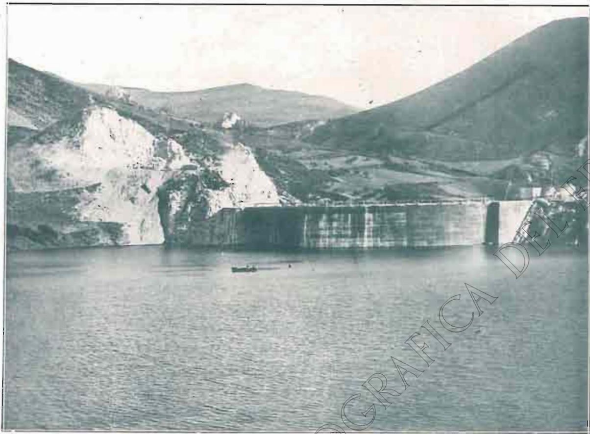
VISTA PARCIAL DEL EMBALSE Y PRESA DE ALLOZ
