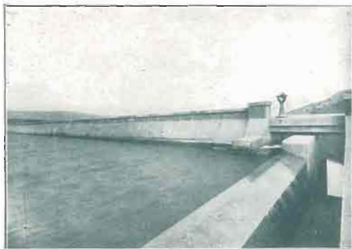
PARAMENTO INTERIOR DEL DIQUE EN EL PANTANO Y ALIVIAMIENTO DE SUPERFICIE
