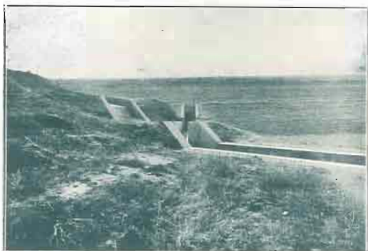
PANTANO DE AMÓS SALVADOR: REUNIÓN DE LA DESCARGA SUPERFICIAL Y LA TOMA DE AGUA.
