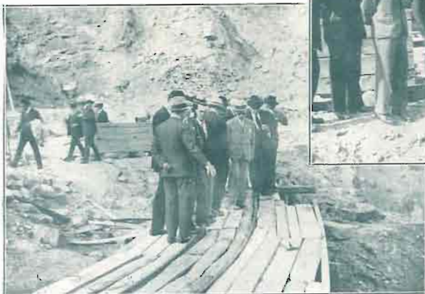
LOS EXPEDICIONARIOS RECORRIENDO LAS OBRAS DEL PANTANO DE YESA.
