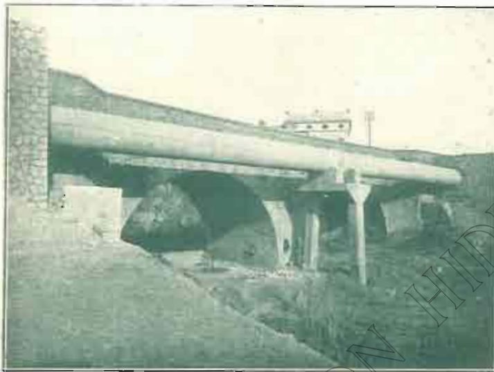
Das tramas de 17 m. Diámetro interior 1,25 m.
