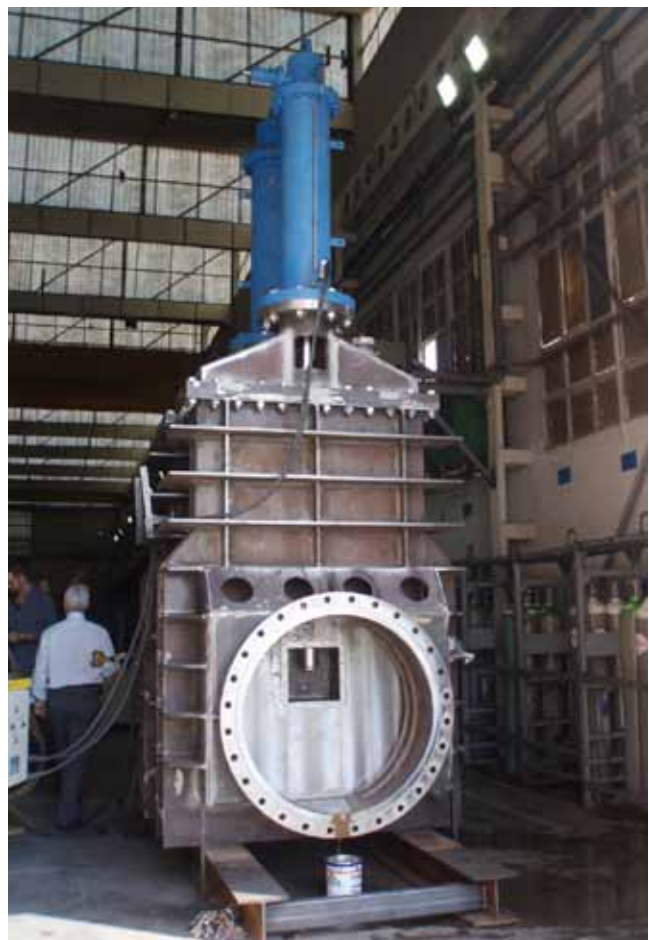
Obras de emergencia para la reparación de las válvulas de los desagües de fondo de la presa de Guiamets (Tarragona).
