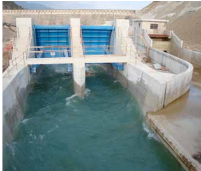
Obras complementarias recrecimiento presa de Yesa (Navarra)
