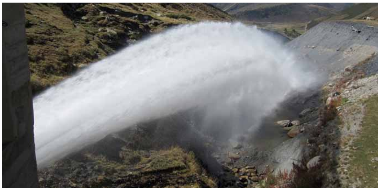
Apertura de la válvula de salida de las aguas del Lago Lanós hacia Francia. Control anual.
