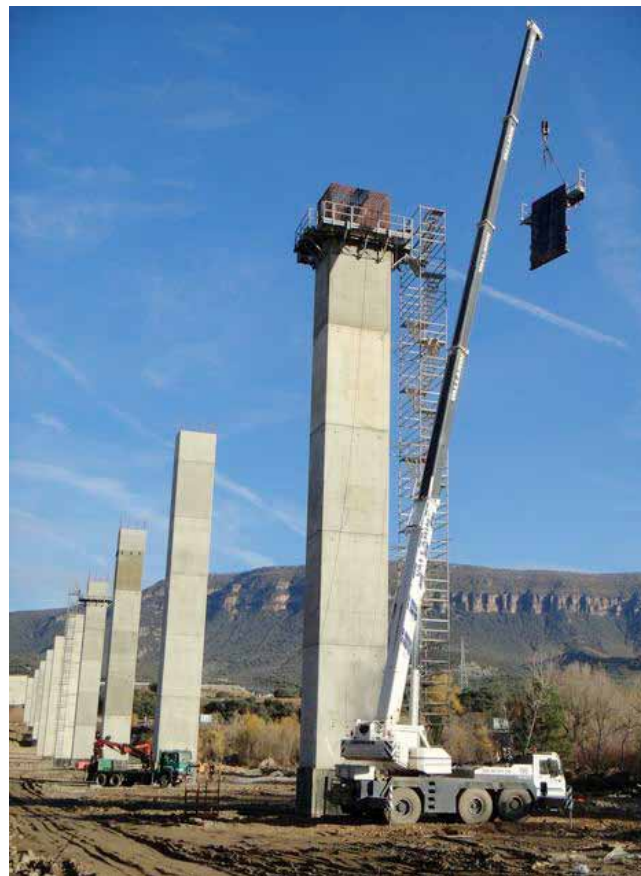
Obras reposición carretera A-1601
