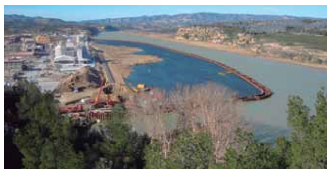
Estado de las obras de descontaminación del embalse de Flix.
