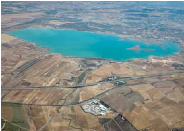
Presa de La Loteta y conducción al Canal Imperial de Aragón
