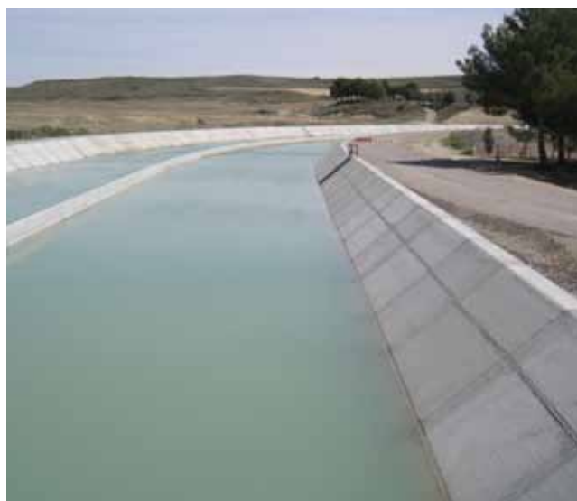
Adecuación del Tramo I del Canal de Monegros. 1ª Fase (Huesca).
