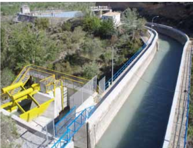
Modernización y acondicionamiento sistemas de compuertas.
