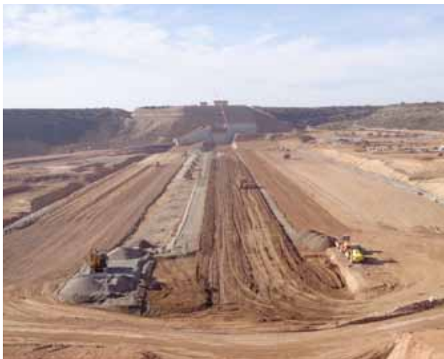
Obras embalse de Valdepatao (Huesca)
