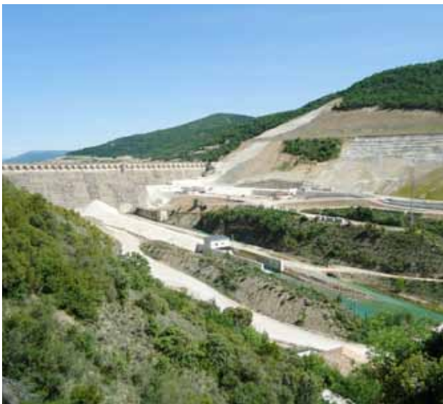
Recrecimiento de la presa de Yesa (Navarra)
