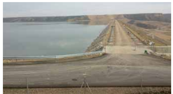
Regulación integral y modernización Canal de Terreu.
