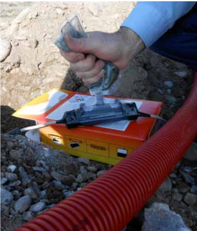
Presa de Sotenera: Recuperación de piezómetro de cuerda vibrante que había resultado dañado en trabajos en la berma de la presa.
