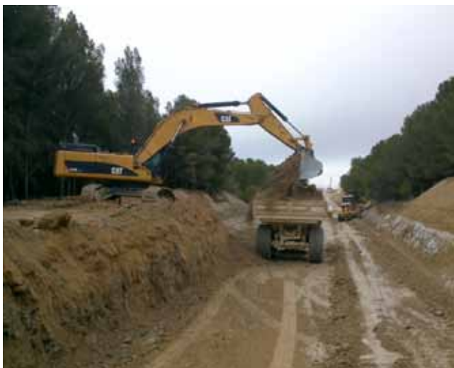
Ampliación del camino CG-2 y su reconversión a carretera comarcal (Zaragoza).
