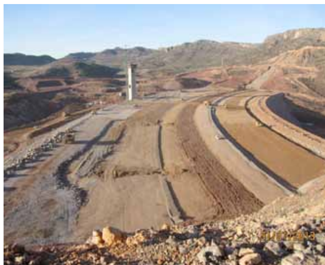
Obras del embalse de Mularroya y azud de derivación (Zaragoza)
