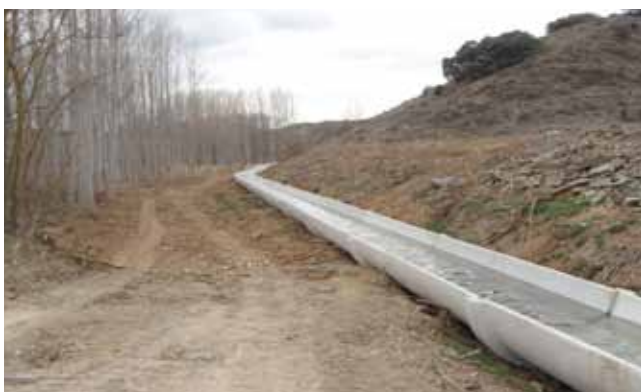
Restitución territorial obras del embalse de Lechago, 1ª parte (Teruel).
