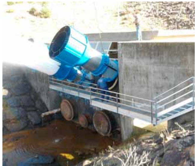
Presa de Pajares (La Rioja). Obras de reparación y acondicionamiento desagüe de fondo
