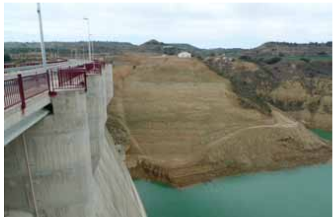
Galerías de impermeabilización en la presa de Montearagón (Huesca)
