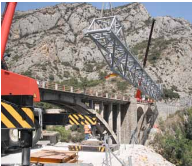
Instalación de una toma intermedia en la presa de Oliana
