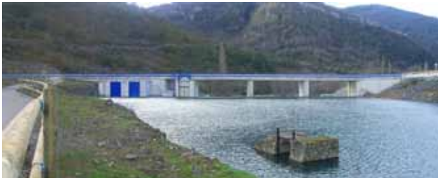
Diques de cola en presa de Itoiz (Navarra)
