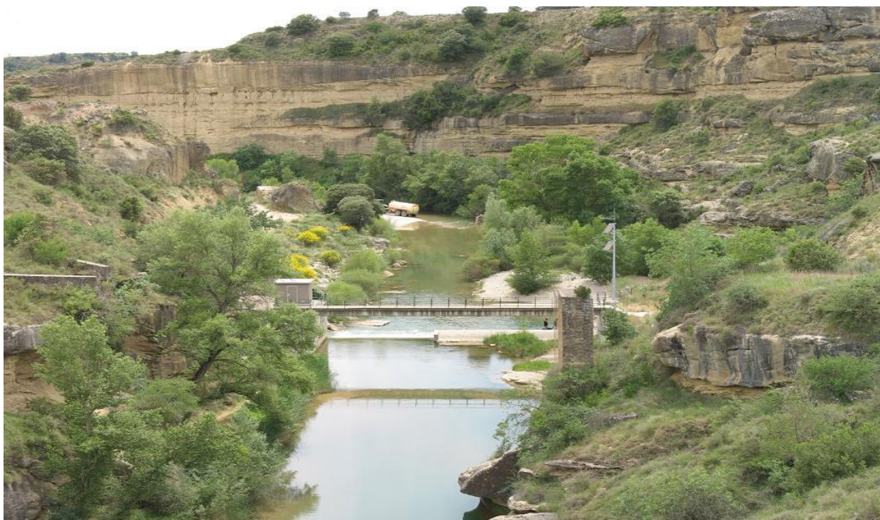
Figura 22-8. Cauce encajado, estación de aforos y estrecho corredor ribereño en el entorno de la carretera N-240.
