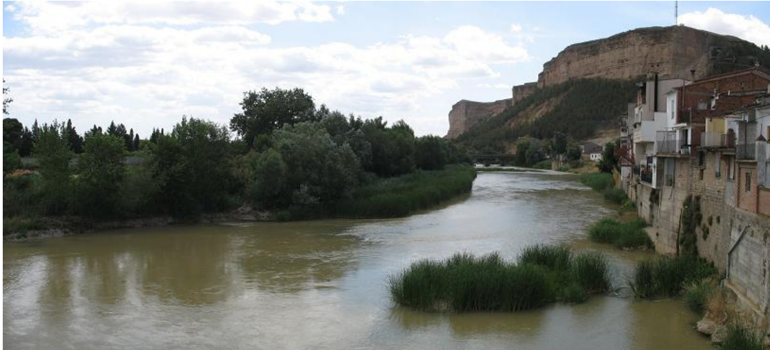
Figura 22-14. Defensas laterales en el río Alcanadre a la altura de la localidad de Ballobar.
