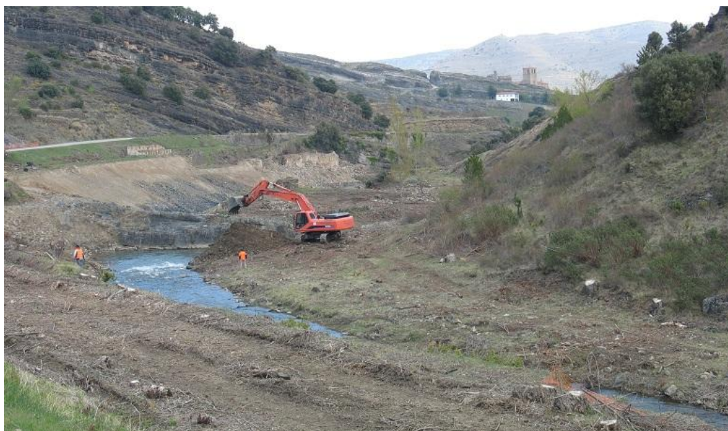
Figura 28-1. Obras de la presa de Enciso. Alteración total de cauce y riberas.
