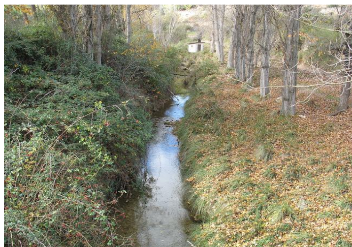
Figura 39-15. Cauce y riberas del río Pena. Detalle de una plantación de chopos.
