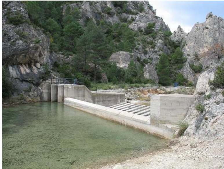
Figura 39-4. Derivación de caudales aguas abajo del Parrisal.
