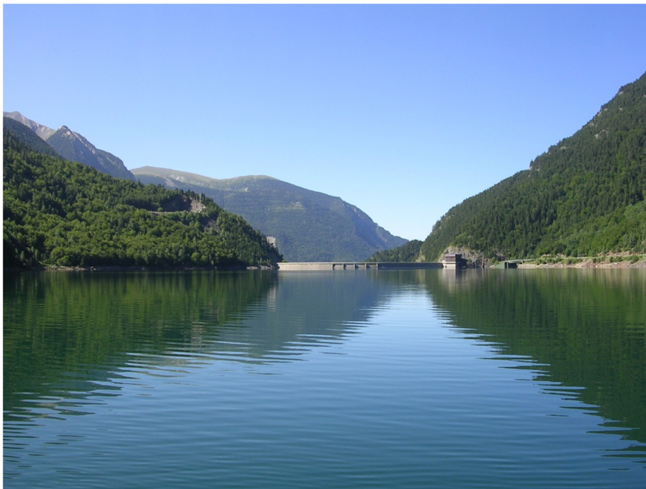
Figura 7. Vista de la presa del embalse
