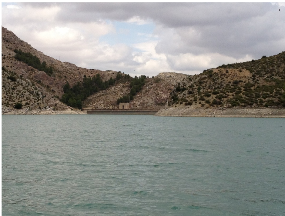
Figura 7. Vista de la presa del embalse
