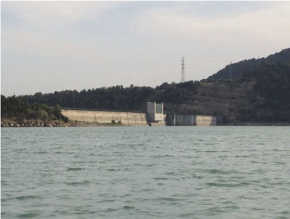
Figura 7. Vista de la presa del embalse
